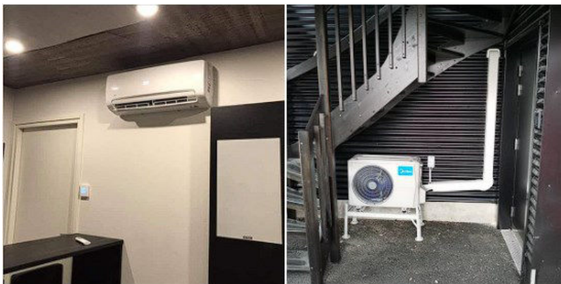
Kuva 2. Ilmalämpöpumpun asennus (Sähkö Optima 2022.)
