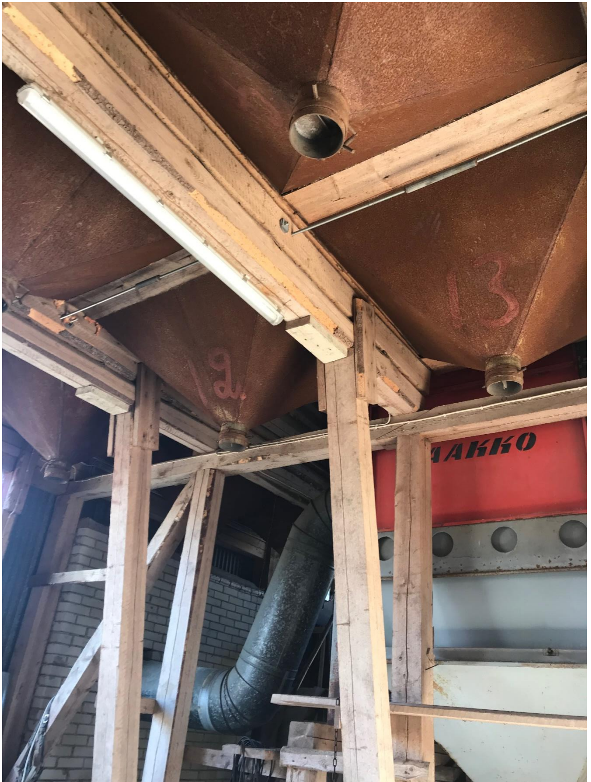
Kuva 13. Siiloista kuva. Jokainen siilo on erikseen numeroitu, mutta numeroiden haalistumisen vuoksi olisi hyvä maalata numerot uudelleen
