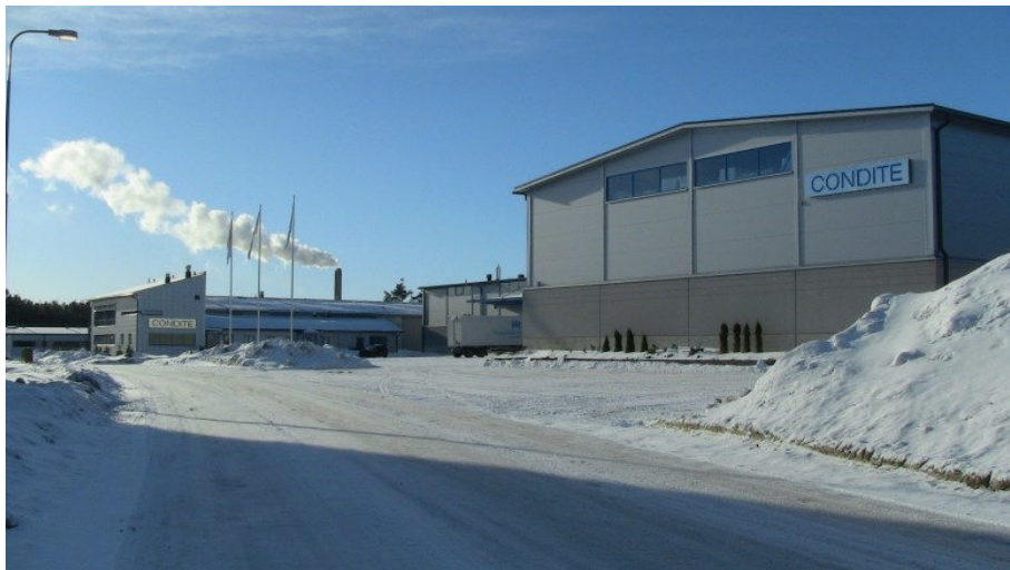
Kuva 1. Conditen varasto- ja toimistorakennus, kohde 2. (Raision valmis-asennus 2020, Condite Naantali.)
